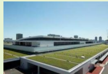
公共施設の壁面緑化等(豊洲市場)
